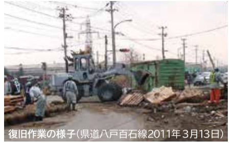
復旧作業の様子(県道八戸百石線2011年3月13日)
