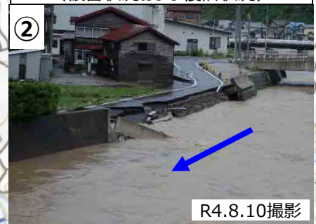
下流部右岸護岸崩壊箇所 (被害状況および復旧状況)
