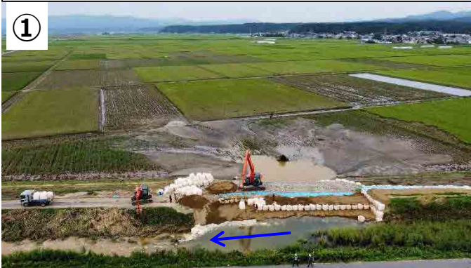
応急仮締切 作業状況 8月16日
