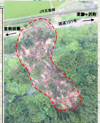
国道101号迂回路（深浦町黒崎地内）
