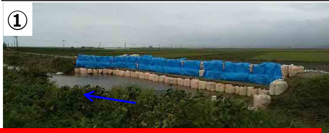
応急仮締切 作業状況 8月16日
