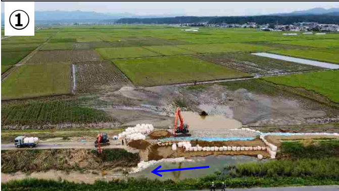
応急仮締切 作業状況 8月16日
