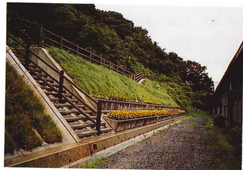
■コンクリート法枠の中を緑化し、周辺景観との調和を図っている
