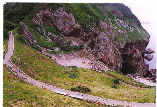
■園路の舗装、柵を周辺との景観と調和させている
