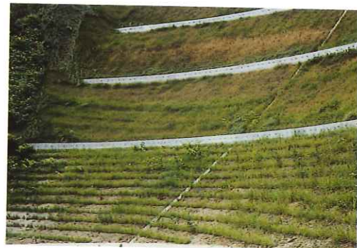
■法面を緑化し、周辺の緑の保全に配慮している
