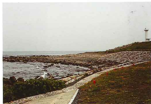
■自然石を用いた護岸の整備により、良好な海浜の保全を図っている
