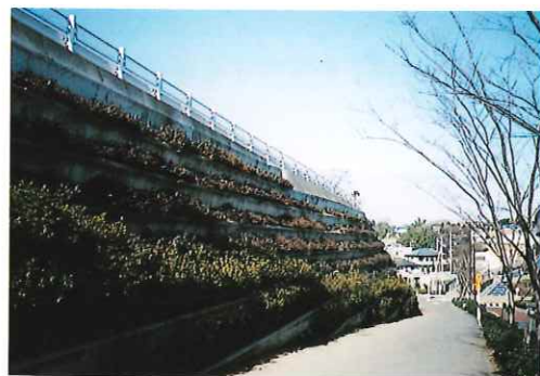
■緑化ブロックにより周辺景観との調和を図っている
