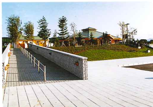
■車いすでも建築物へ入れるようスロープを設置している
