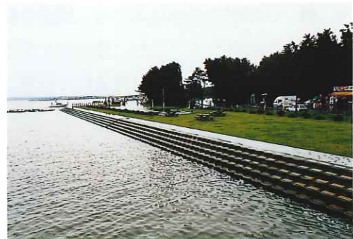
■ 階段護岸の採用により、親水性を確保している
