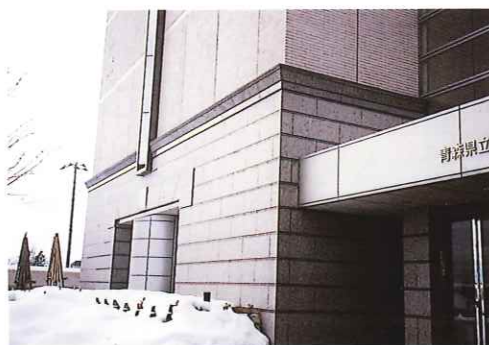
■老朽化の目立たない素材を使用している
