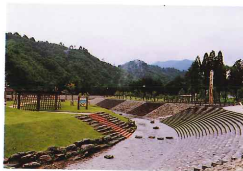
■ 堰堤 えんてい に続く流路工に自然素材を用い、周囲の自然景観との調和を図っている
