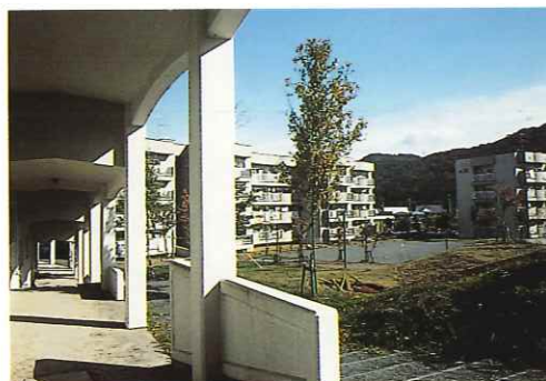
■防雪通路が建物本体と一体的なデザインとなっている
