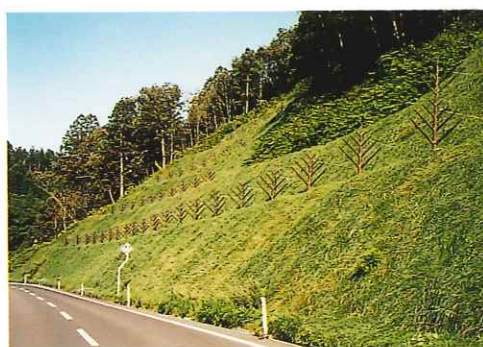
■雪崩防止工のデザインの工夫により、冬期以外における周辺景観との調和を図っている
