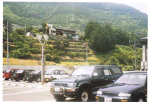
■地形を分節化し、擁壁の高さを低くすることにより、周辺景観との不調和の軽減を図っている
