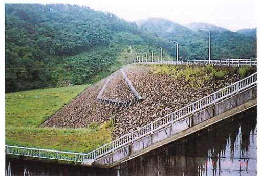
■ダム本体が周辺景観と調和した形態となっている
