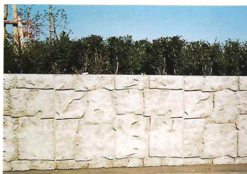
■化粧型枠の使用により、圧迫感を和らげている
