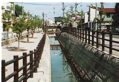
■ 化粧型枠による表面処理を施し、周辺との調和に配慮している
