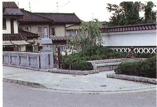
■デザインの工夫により、橋りょう部と道路部の調和を図っている
