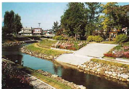
■ 階段護岸の採用により、親水性を確保している
