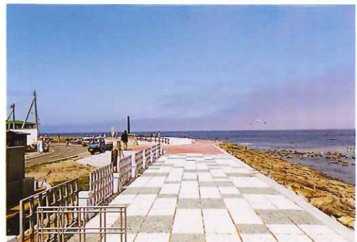
■ 石材を用いた緩傾斜護岸により、海と陸の連続性に配慮されている
