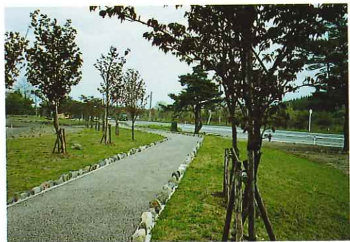
■ 舗装端に自然石を活用し、かつ舗装材を工夫することによって、自然景観と調和させている
