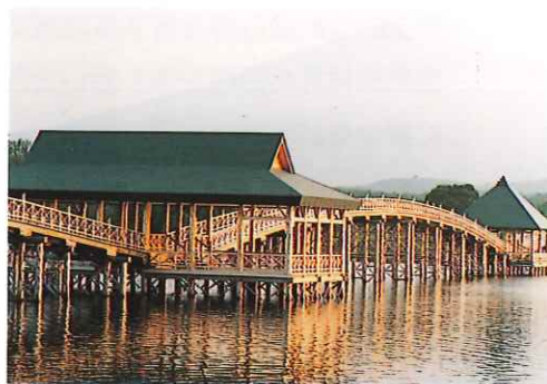
■展望施設自体のデザインの工夫により、周辺との調和が図られている
