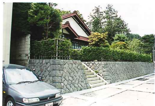
■石積擁壁により自然景観との調和を図っている
