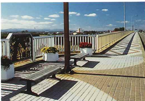
■橋上に小広場を設け、眺望点としての機能の創出を図っている
