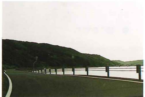
■ ガードロープにより眺望を阻害しないよう配慮している
