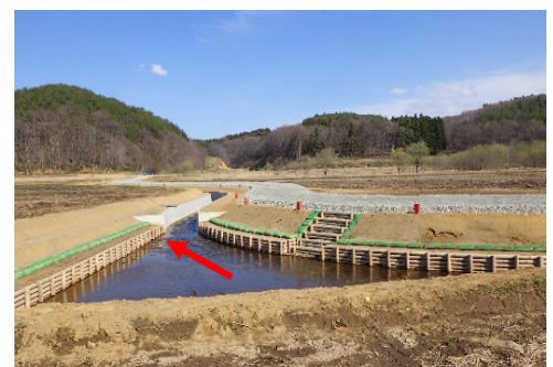
環境配慮施設（完成）
