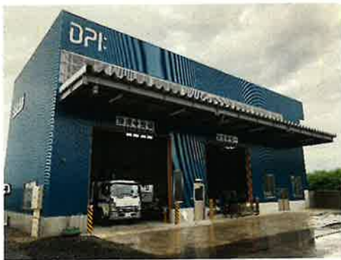
配管加工場（外観）
