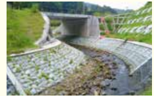
第0434014号 SC-河川景観に配慮したコンクリートブロック(張りブロック)
