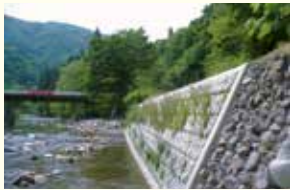
第0434013号 SC-河川景観に配慮したコンクリートブロック(積みブロック)
