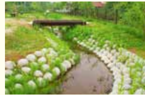
第0434014号 SC-河川景観に配慮したコンクリートブロック(張りブロック)
