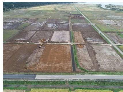
工事後 (直線化した排水路)
