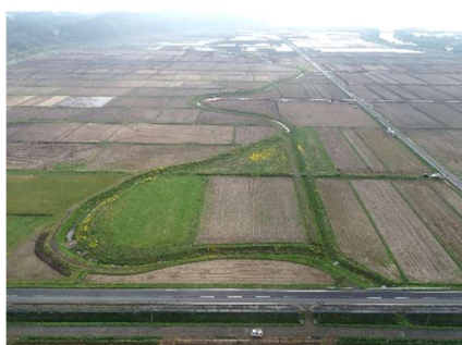
工事前 (大きく蛇行する排水路)
