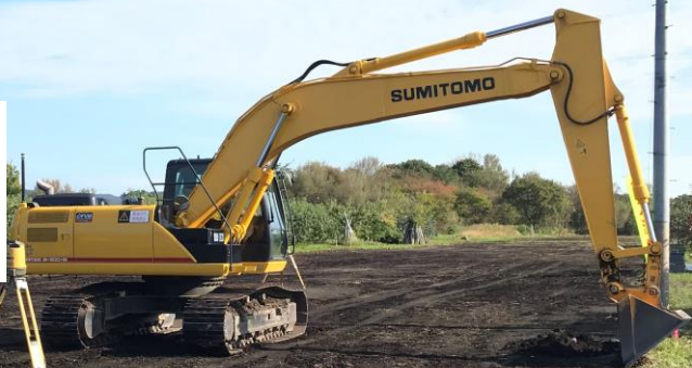
写真：常海橋銀線 施工現場
