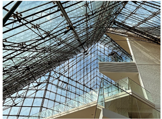
【写真2-2】「ガラスのピラミッド」の内側の様子
