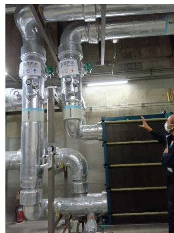
【写真2-4】新千歳空港の雪冷熱供給システムの熱交換システム
