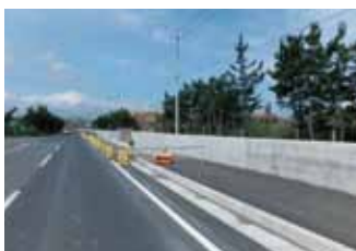
防潮堤整備工事の様子
