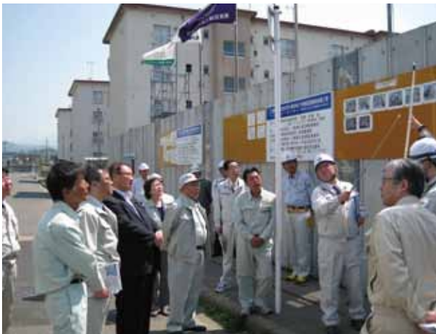
県営住宅小柳団地建替事業の現場視察
