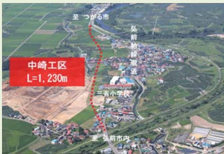
弘前柏線 中崎工区 バイパス整備箇所
