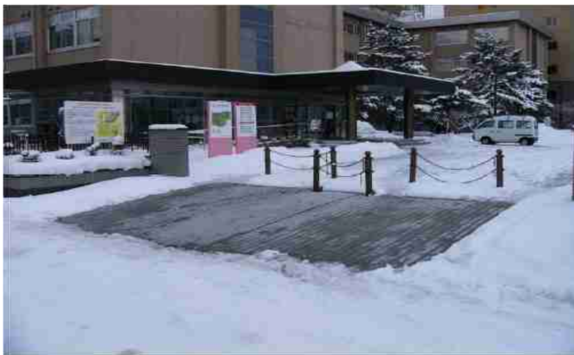
図 1.4.1.1 弘前大学敷地内における融雪状況
