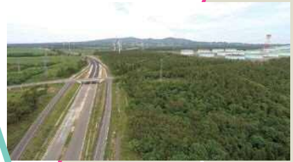
下北半島縦貫道路
