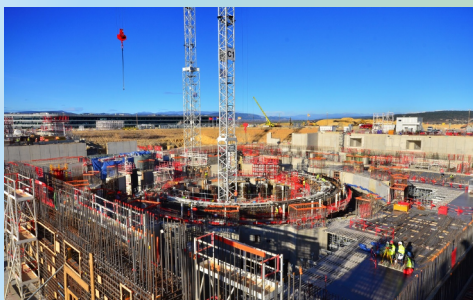
ITER本体建屋建設の様子(提供:ITER機構)
