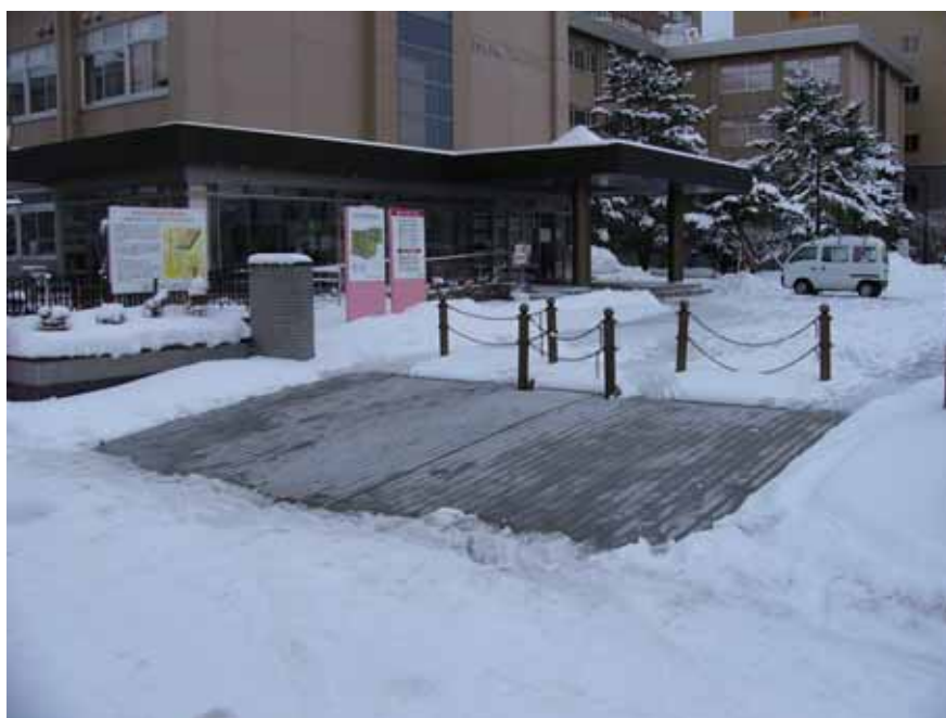
図 3-12 弘前大学敷地内における融雪状況
