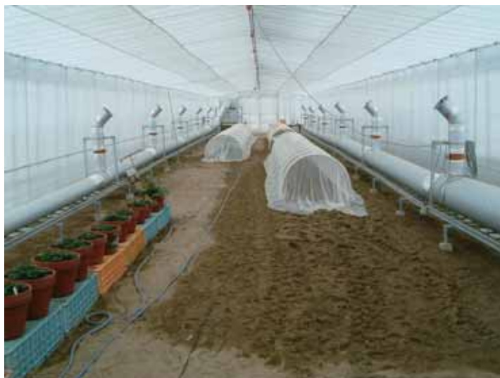
図 3-15 地中熱利用システムによるハウス栽培状況
