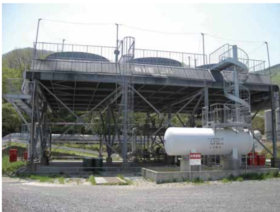
図 2-8 八丁原発電所構内のバイナリー発電設備
