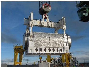
むつ小川原港での荷揚げ作業
