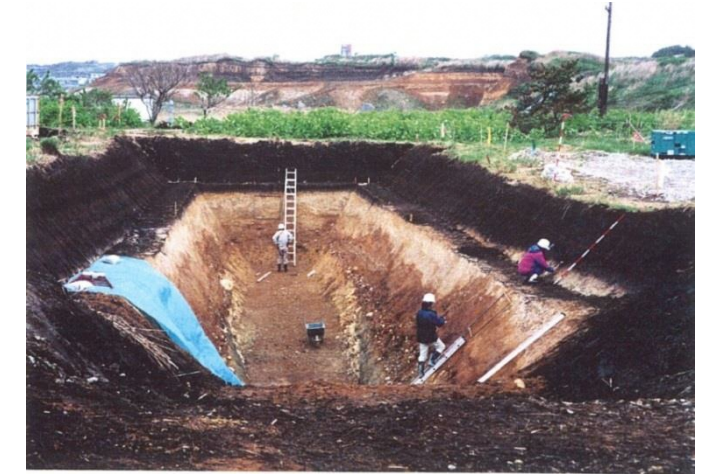
図3 トレンチ調査作業状況(事例)
