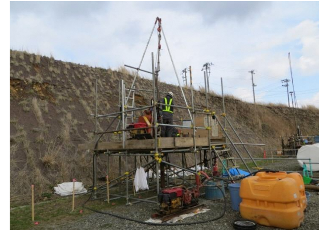
図2 ボーリング調査作業状況(事例)
