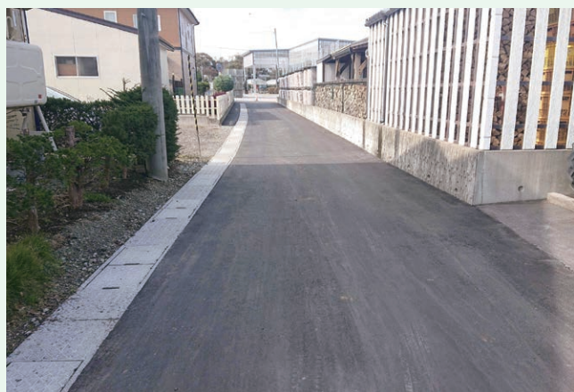
町道維持補修工事事業(おいらせ町)
