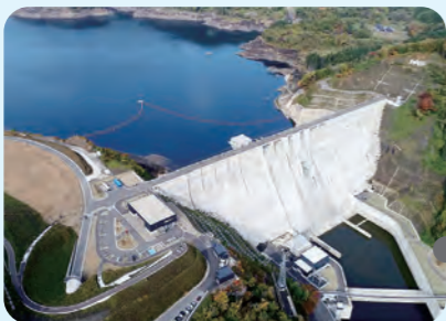
■津軽ダムと津軽発電所 (西目屋村)
