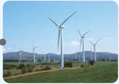
■六ヶ所村二又風力発電所 (六ヶ所村)
