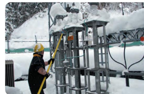
変電設備の上に積もっている雪を片付けている様子
