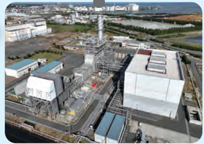
■八戸火力発電所 (八戸市)
