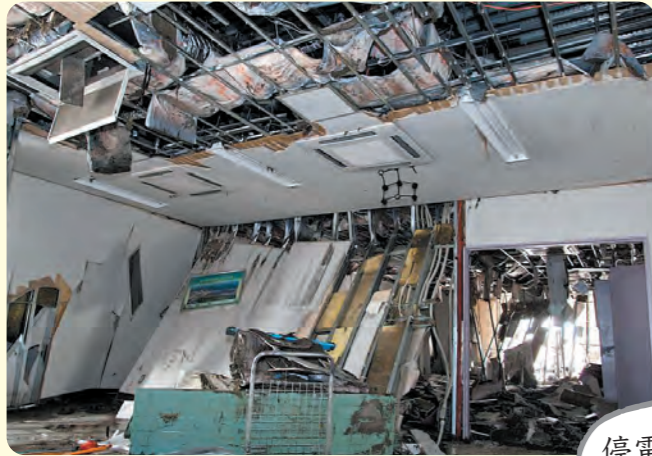
地 つなみ しんや津波のひ害を受けた仙 せんだい 台火力発電所
