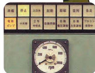
ダムの水不足で 発電停止中
