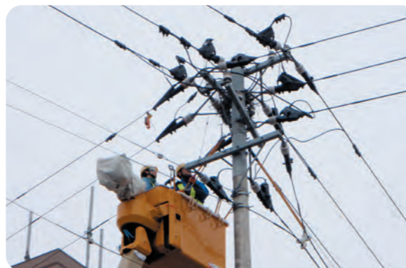
電線にあるカラスの巣を取り除いている様子
