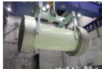
天井クレーンによるたて起し架台への 移動作業
