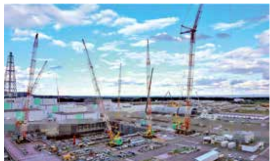
MOX工場（建設中写真）
