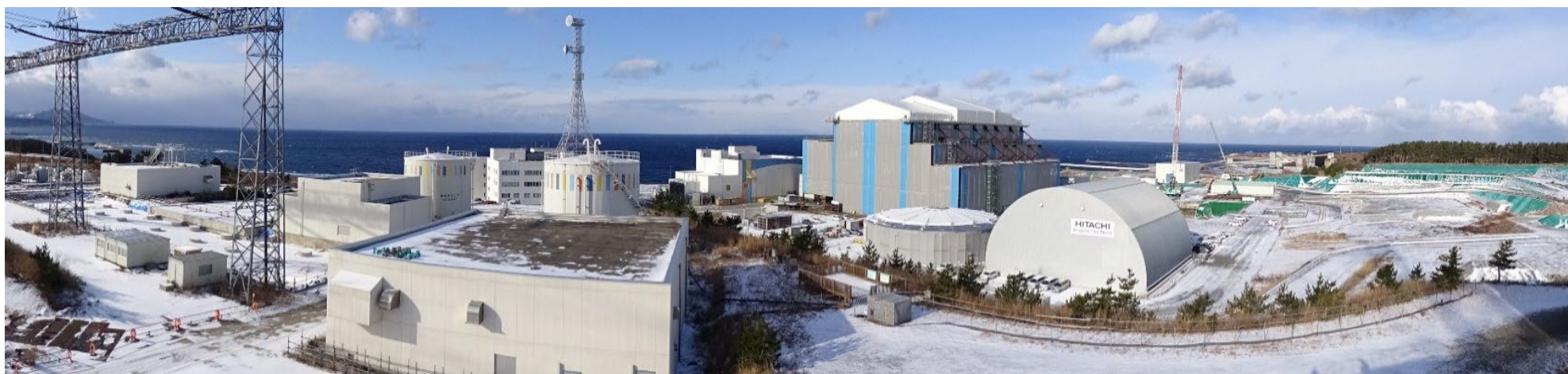
工事状況写真（2025年1月撮影）
