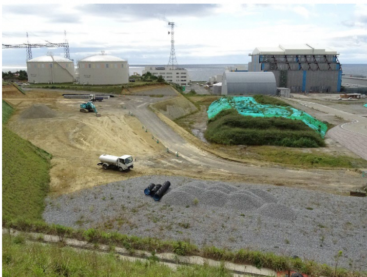
敷地造成工事
