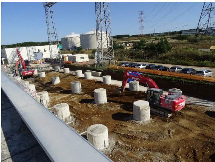
開閉所遮風建屋基礎工事
