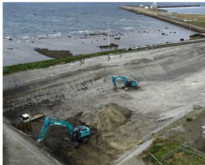
主建屋西側敷地造成工事
