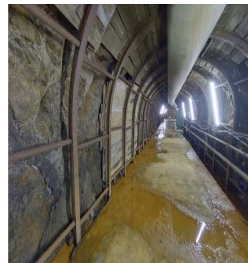
試掘坑内部の様子
