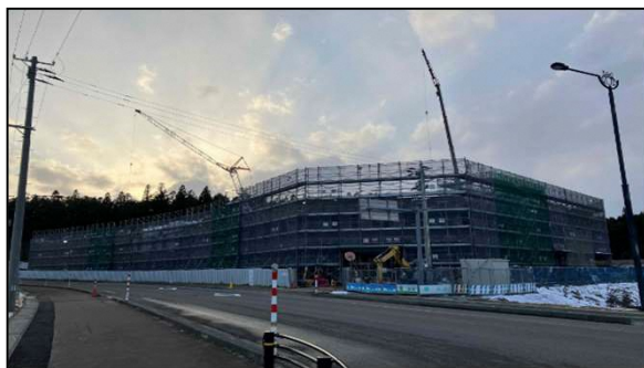
オフィス棟工事現場
