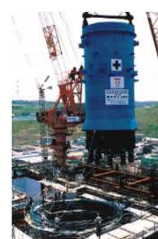
原子炉圧力容器据付
