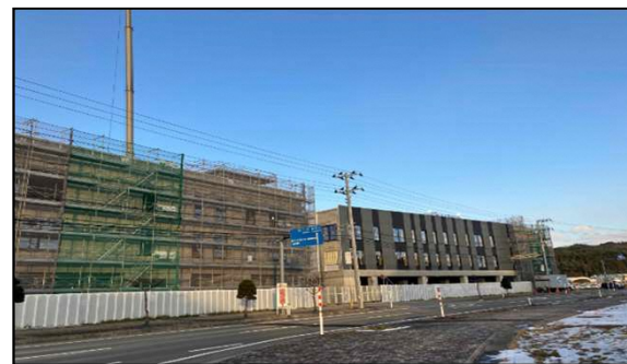
住居・交流施設棟工事現場
