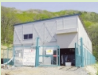
仮設浄化プラント (H17.7撤去)
