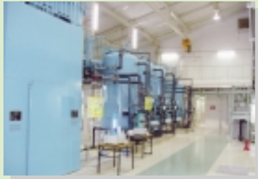
浸出水処理施設内部
