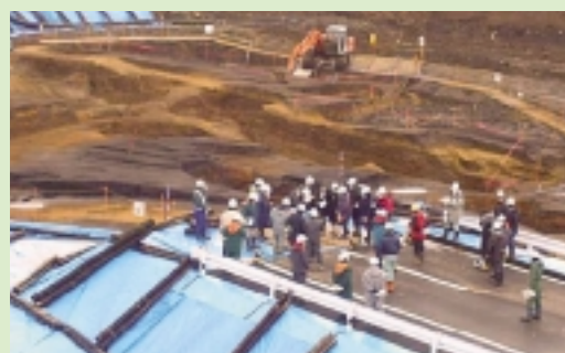
(H22.12.7 第5回地山確認の様子)
