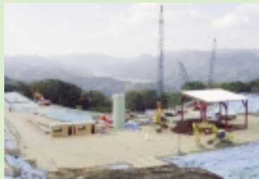
平成17年10月の遮水壁工事状況
