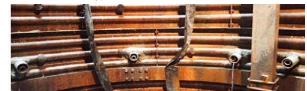
横ボーリングの状況
