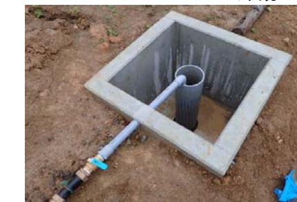
注水井戸柵内部の状況
