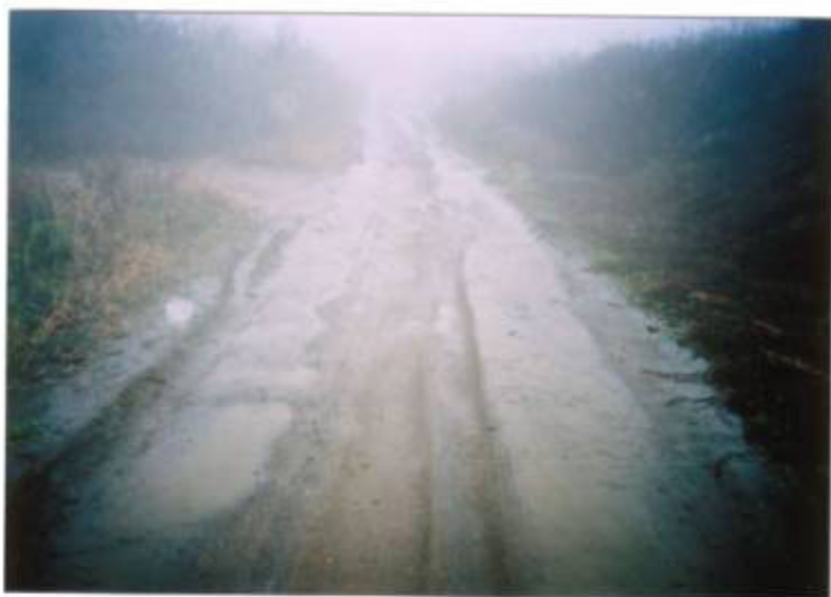
③E区より南方を望む。地表水が集中する箇所では流量は約80ℓ/分程度である。
