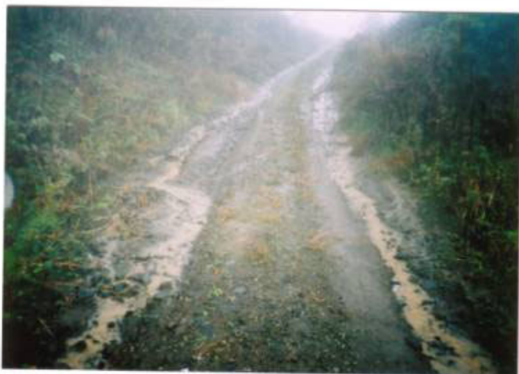
①現場入口付近：県境付近を流れる地表水 約90ℓ/分の地表水が北流して貯水池に流入する。
