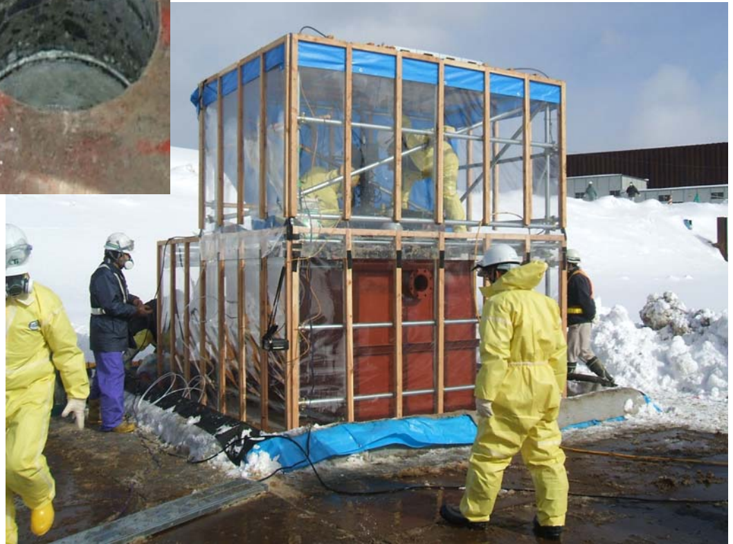
削孔作業状況
