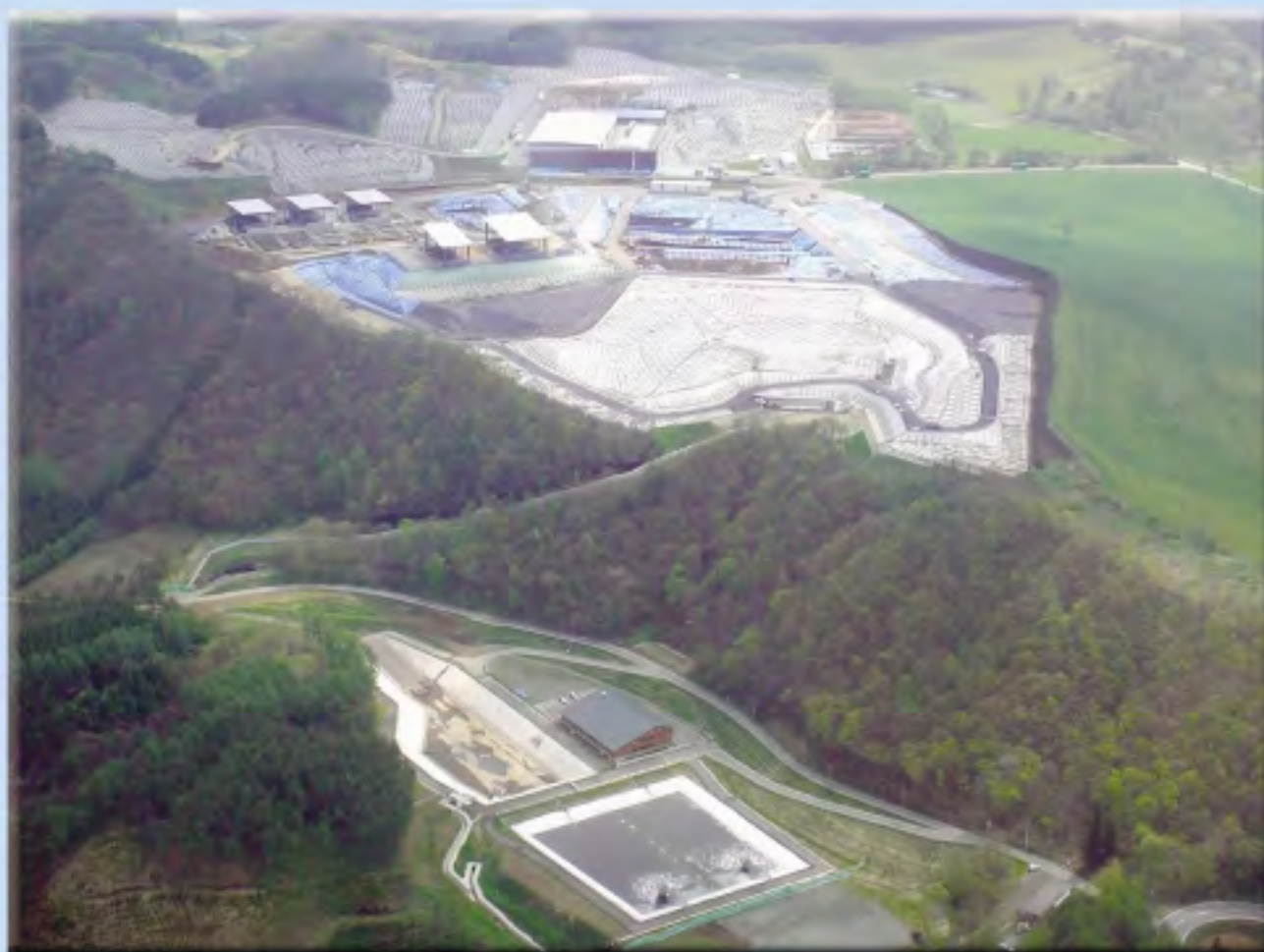
平成19年5月の不法投棄現場全景
