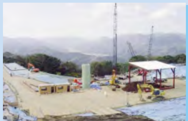
平成17年10月の遮水壁工事状況
