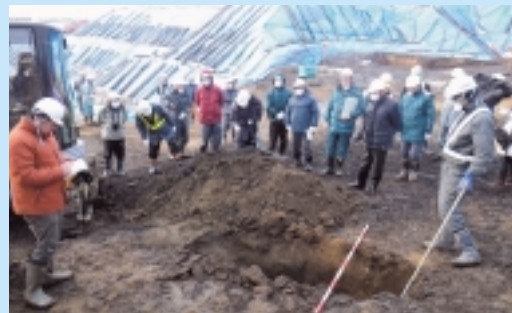
H23.12.7 第6回地山確認(試掘)
