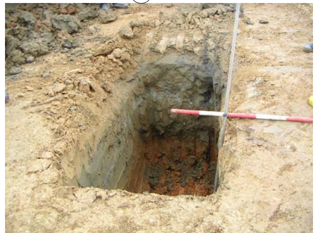
試掘 (b) 完了 (H=2.0m)
