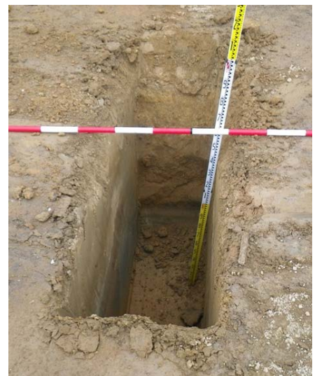
試掘完了（H≒1.5m）
