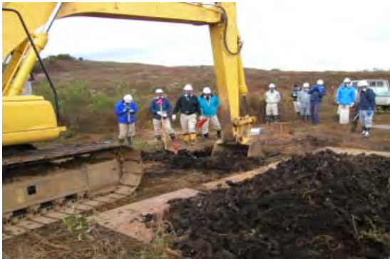
写真1 重機掘削状況
