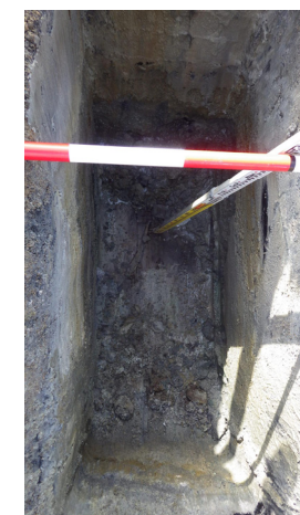
試掘完了（H≒1.5m）
