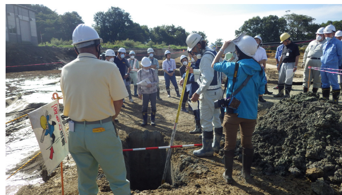
【試掘箇所確認状況（西側エリア）】
