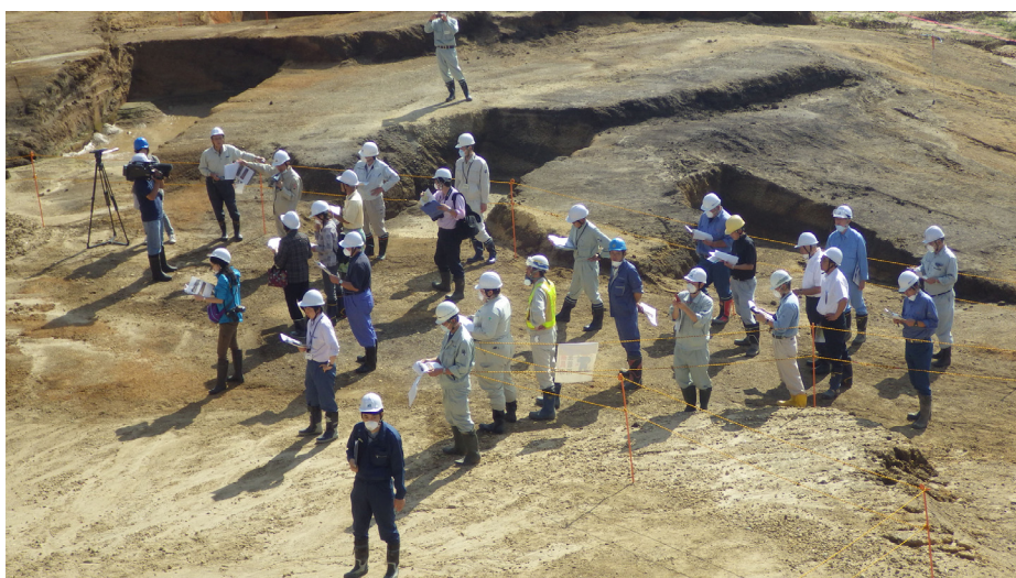
【地山確認状況（旧洗車場西側エリア）】
