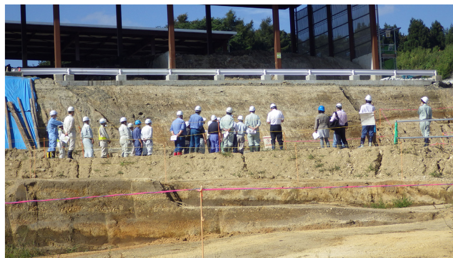
【地山確認状況（選別施設南側エリア）】
