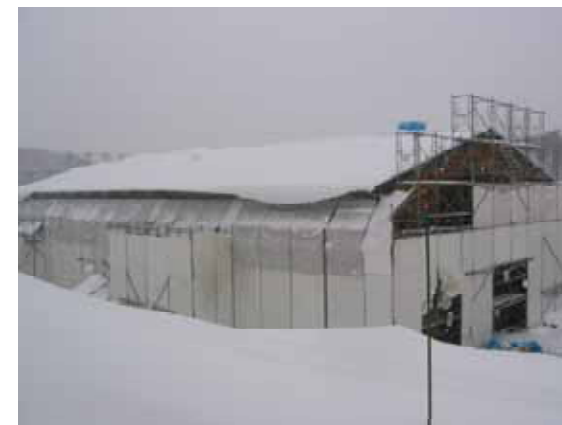
浸出水処理施設(H17年5月完成予定)
