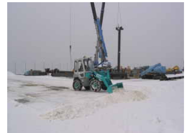
廃棄物処理委託工事(H17年3月完成予定)
