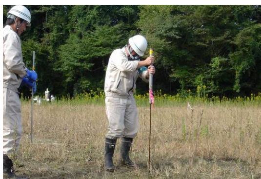
① ボーリングバーの貫入
