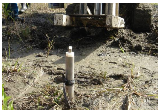
② 保護管の設置
