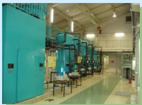
浸出水処理施設内部
