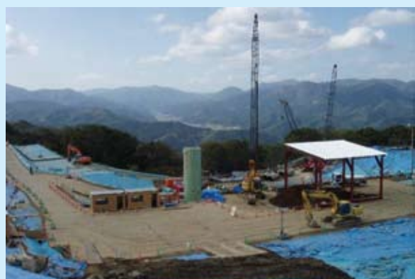
平成17年10月の遮水壁工事状況
