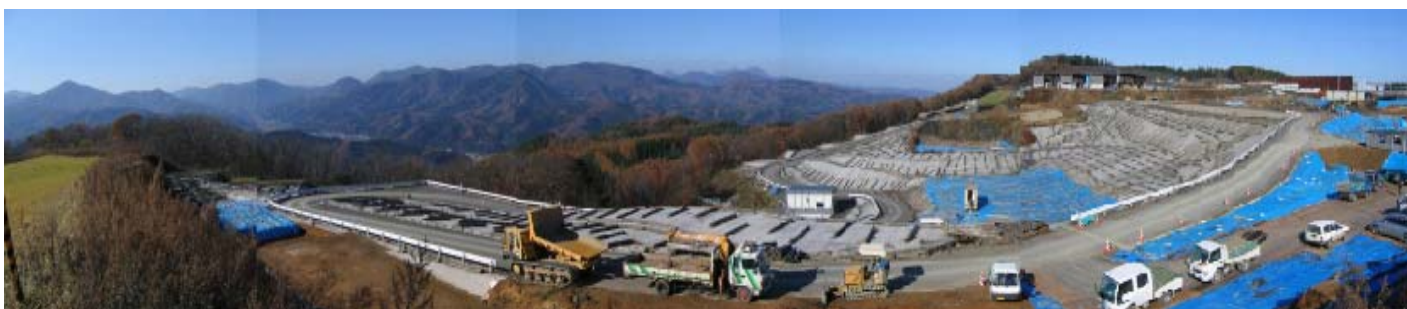
現場全景 (平成21年11月)
