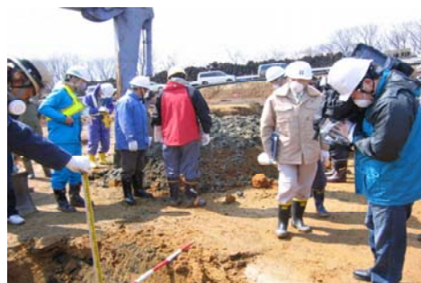
地山確認の様子
