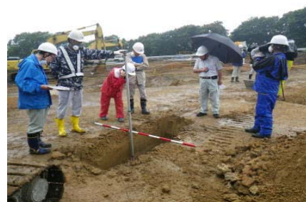
試掘箇所確認状況（中央部）
