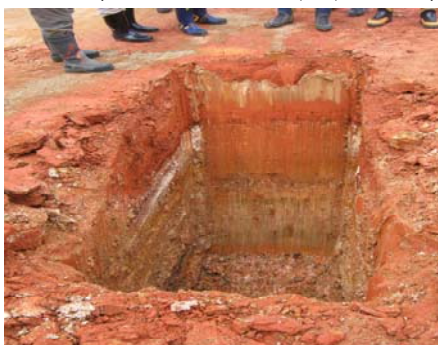
掘削した地山（6月20日）
