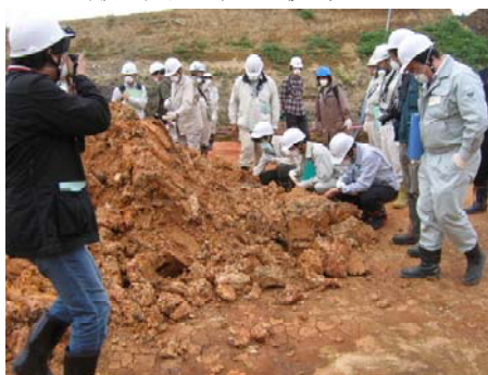
掘削した地山の確認の様子（6月20日）
