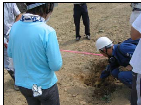
覆土の確認の様子（8月27日）
