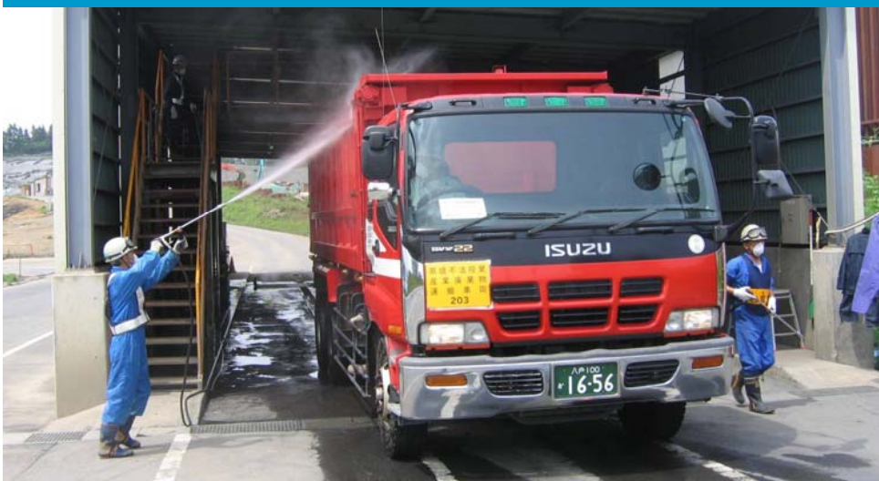
汚染物が場外に出ないように洗車場を設置
