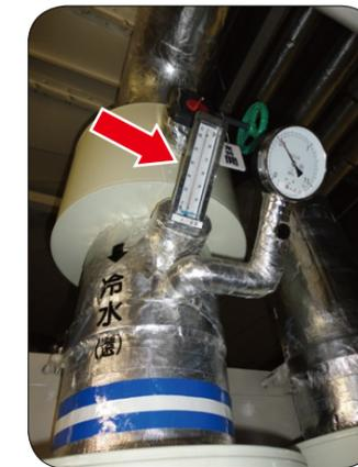
写真-D 冷水入口温度
