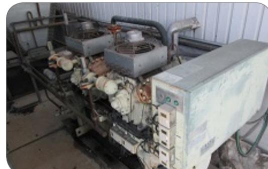
開放型冷凍機異常振動、異常運転音の確認
