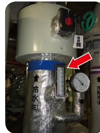
写真-C 冷水出口温度
