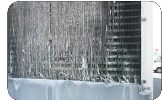
室外機の熱交換器表面の飛散水による腐食
