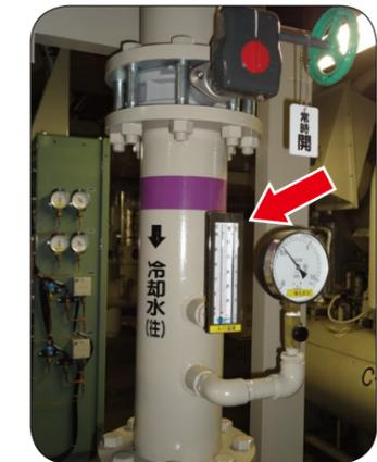
写真-E 冷却水入口温度
