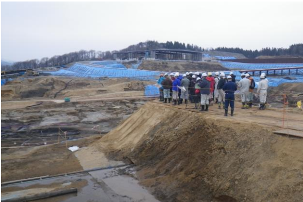
地山確認状況 (全体説明)
