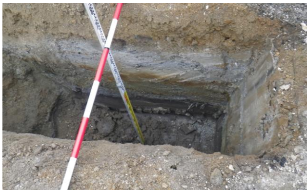
試掘完了 (H ≒ 1.5m)
