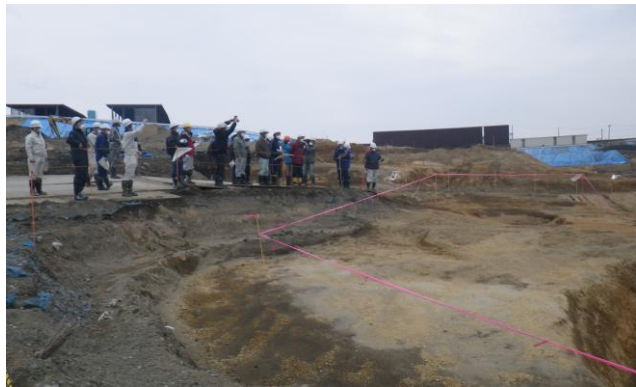
地山確認状況
