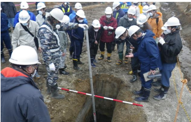
試掘箇所確認状況
