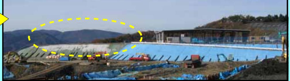
5月まで利用していた旧撤去ヤードの解体・撤去工事が終了しました。鉄骨組みの建屋二棟と敷き鉄板を解体・撤去し、撤去後はシートでキャッピングを行っています。（右写真）
