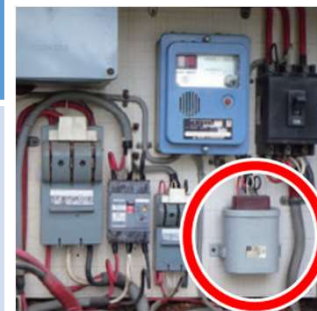
低圧分電盤内の低圧コンデンサー
