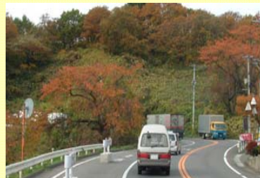
縦断勾配9% 事故危険箇所2箇所
